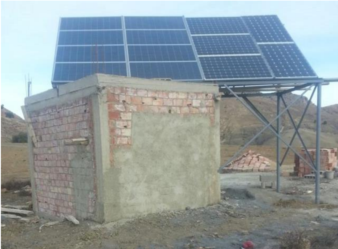
Waterput Azrou Akachar (Tizi Ousli) inclusief PV installatie.
